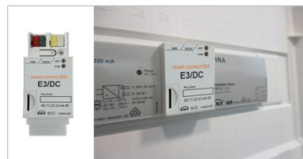
Über ein zusätzliches KNX-Gateway wird das S10 Hauskraftwerk per KNX-Bus in die Hausautomation integriert. Das KNX-Gateway verbindet sich mit dem Hauskraftwerk.
